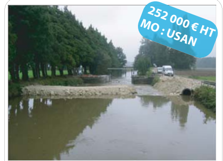
Nouveau barrage de la Motte au bois
