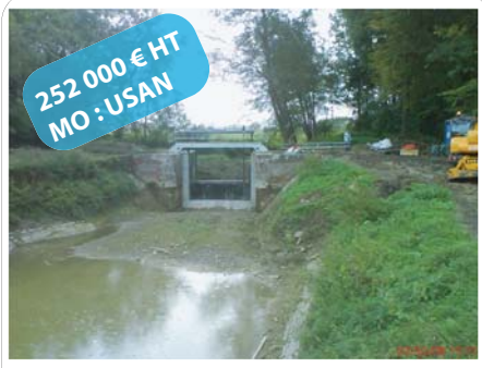
Nouveau barrage du Grand Dam
