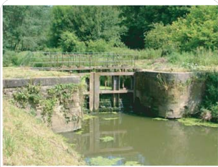
Ecluse du Grand Dam avant travaux
